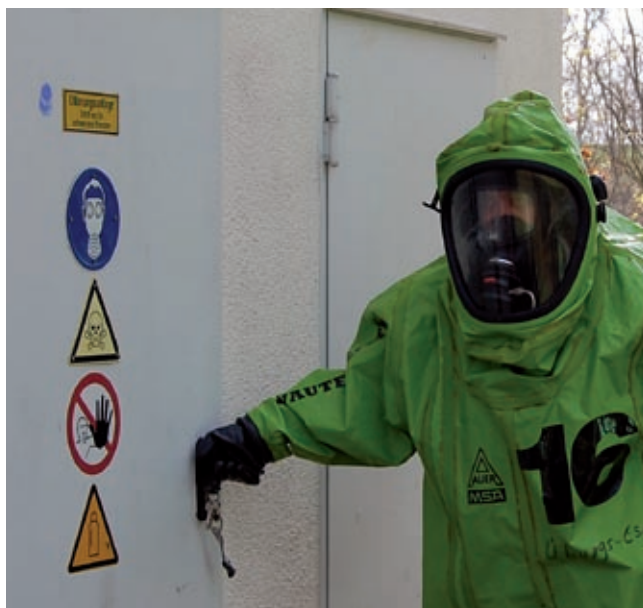
Ein Truppmann an der Tür zum Chlorgasraum in dem sich die leck geschlagene Gasflasche befindet
